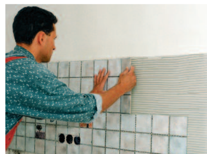
De tegels glijden niet weg en de positie kan nog enige tijd gecorrigeerd worden.
